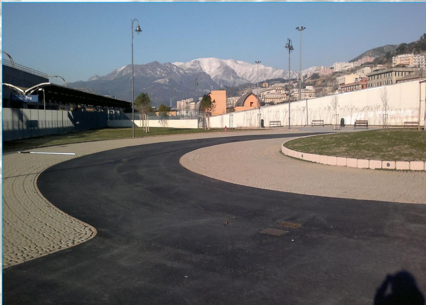
Il progetto ha previsto la realizzazione di un nodo integrato per il trasporto pubblico locale, in particolare un parcheggio auto per l'interscambio, in adiacenza al percorso d'accesso alla stazione RFI. La soluzione progettata di "parcheggio verde" riduce drasticamente gli impatti poiché rende disponibile una superficie pedonabile di qualità, le zone di sosta sono delimitate da una serie di aiuole modellate a "duna", su cui sono presenti alberature di seconda e terza grandezza.
